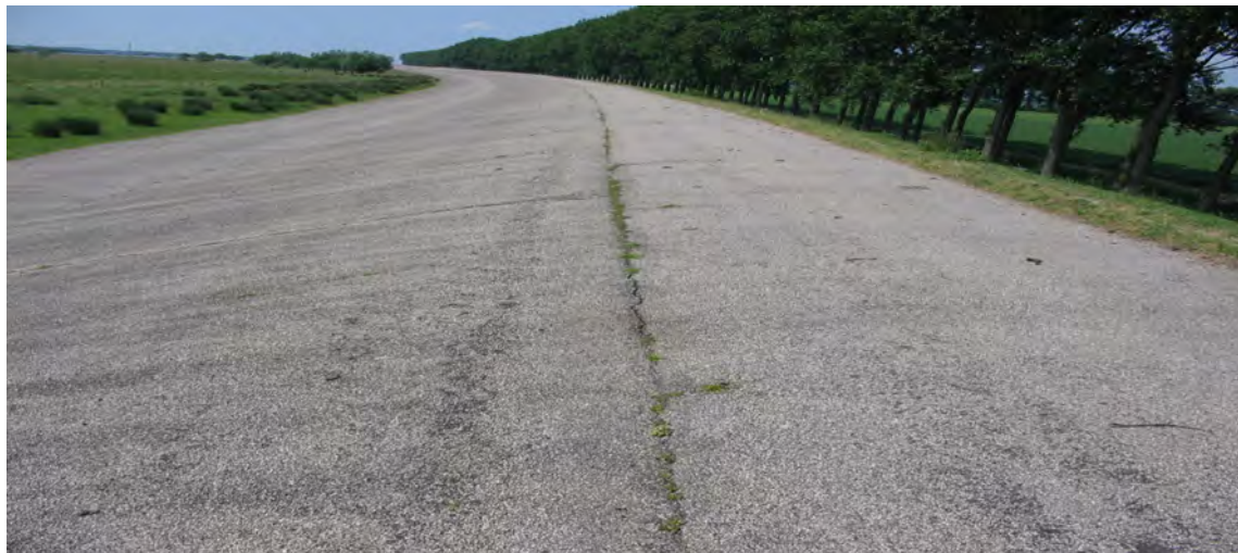
FIGUUR 7 BOUWDEEL BEKLEDING MET MATERIAAL ASFALT OP ELEMENTEN BUITENTALUD EN KRUIJN [FOTO: WS HOLLANDESE DELTA]
