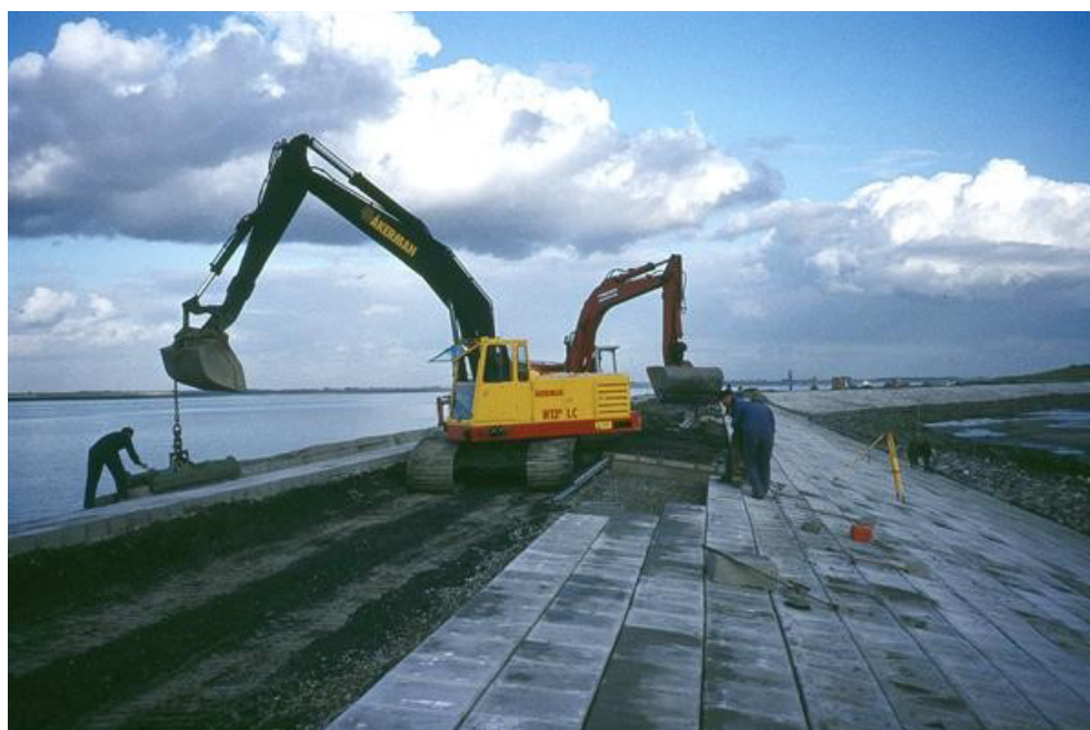
AANLEG PHILIPSDAM MET AANBRENGEN BEKLEDING VAN STEEN OP ELEMENTEN BUITENTALUD EN BINNENTALUD EN DE KRAAN OP DE KRUIN [FOTO: RWS BEELDBANK]
