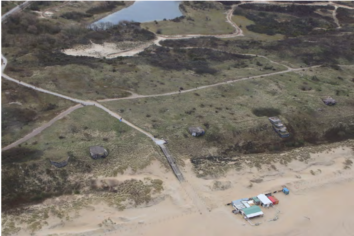
FIGUUR 21 ELEMENTEN ZEESTRAND EN AFSLAGZONE MET DIVERSE BOUWDELEN ZOALS BANKET, TRAP, OPSTAL (BUNKERS EN STRANDPAVILJOEN), ELEMENTENVERHARDING (VERHARDEN PAADJES), AFSCHIEDING (DRAADRASTERS) EN STUIFKUIL [FOTO: HH DELFLAND]
