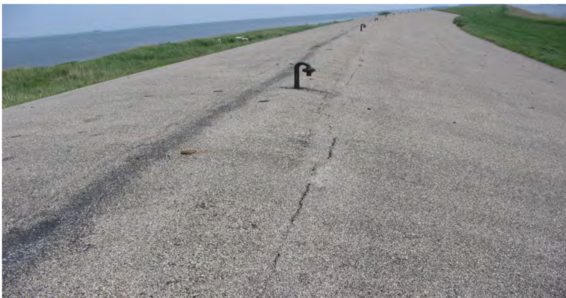
FIGUUR 23 ZIJN DRUKONTLUCHTINGSPIJPJES BELANGRIJK VOOR DE FUNCTIE VAN DE BEKLEDING, NIET-WATERKERENDE OBJECTEN OF HET BOUWDEEL VAN HET ELEMENT KRUIJN? [FOTO: WS HOLLANDE DELTA]
