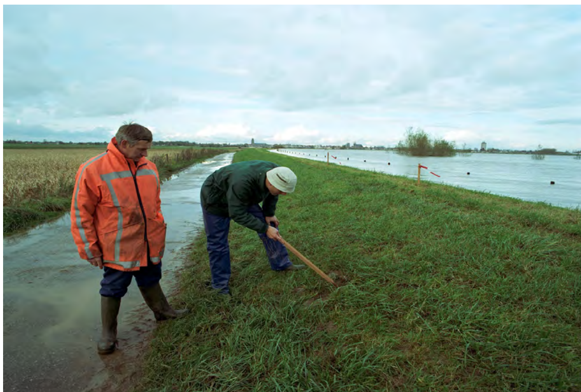
FOTO 2 DIJKINSPECTIE TIJDENS HOOGWATER IJSSEL [FOTO: BEELDBANK RWS]
