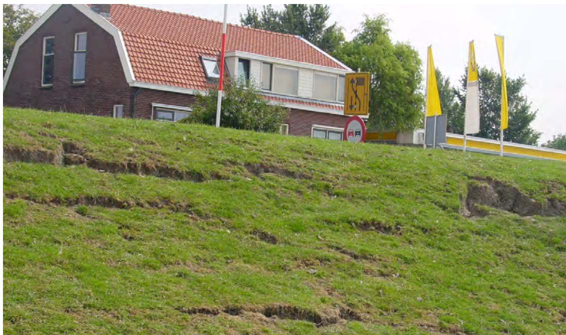
FIGUUR 10 HET GEBREK VERZAKKING KOMT AANZIENLIJK (30-70 %) VOOR [FOTO: HH DELFLAND]
