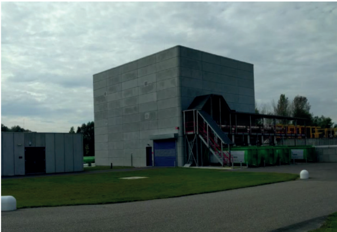
FIGUUR 7.1 FIJNZEEFINSTALLATIE RWZI AARLE-RIXTEL
